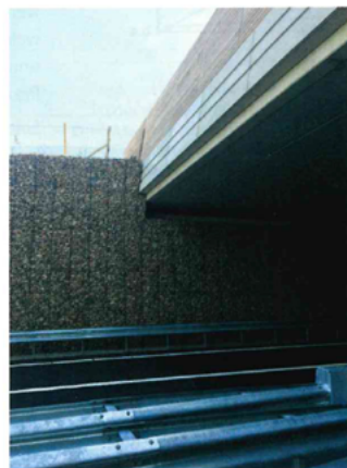
Bild 4: KBE-Konstruktion im Bereich eines der Brückenwiderlager im Projekt Buitenring [Foto: Hangen]
