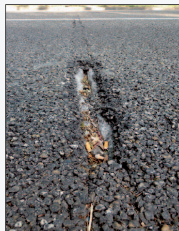
Figure 10, 11 e 12 - In un tratto non rinforzato, si vedono marcate fessurazioni in corrispondenza dei giunti tra le lastre in calcestruzzo dopo quattro anni dall'intervento
