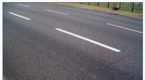
Figure 7 e 8 - Il tratto non rinforzato: le fessurazioni sono già visibili in corrispondenza dei giunti tra le lastre in calcestruzzo dopo dieci mesi dall'intervento
