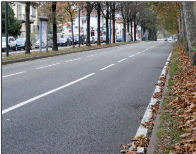
Figura 13 - Il tratto rinforzato con HaTelit®: la pavimentazione in condizioni perfette e le fessurazioni non sono visibili dopo cinque anni dall'intervento
