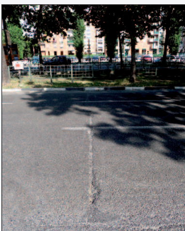
Figure 10, 11 e 12 - In un tratto non rinforzato, si vedono marcate fessurazioni in corrispondenza dei giunti tra le lastre in calcestruzzo dopo quattro anni dall'intervento
