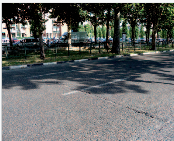
Figure 10, 11 e 12 - In un tratto non rinforzato, si vedono marcate fessurazioni in corrispondenza dei giunti tra le lastre in calcestruzzo dopo quattro anni dall'intervento
