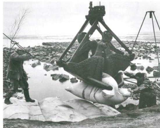
Figuur 2 – Detail plaatsing zandzakken
