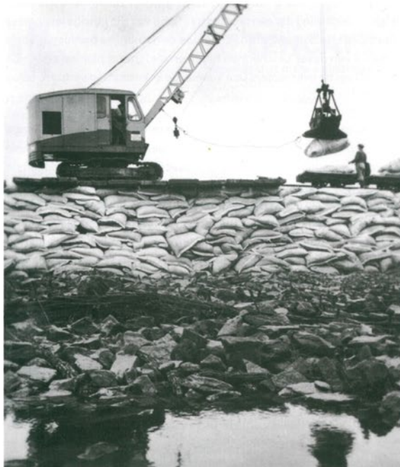
Figuur 1 – Dragline op schotten Pluimpot 1957.
