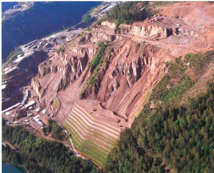
Figuur 5 – 60 m hoge steile ophoging in Trento.
