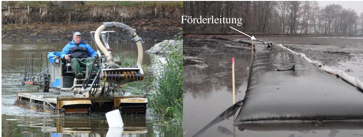
Abbildung 4: Amphibischer Saugbagger und geotextiler Schlauch während der Befüllung
