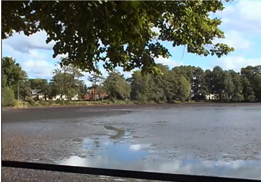
Abbildung 1: Zustand Schmelzteich Bernsdorf vor der Sanierung 2012
