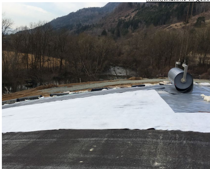
Figura 2. Posa del capping. Il geocomposito bentonitico NaBento RL-C con 11 kg/m 2 di bentonite calcica (nero) è visibile in primo piano. Dietro è visibile il geocomposito attivo Tektoseal Active AC con 2 kg/m 2 di carboni attivi (bianco). Nella foto si può vedere anche la membrana LDPE (grigia) con incorporato uno strato di alluminio impermeabile ai CHC.
