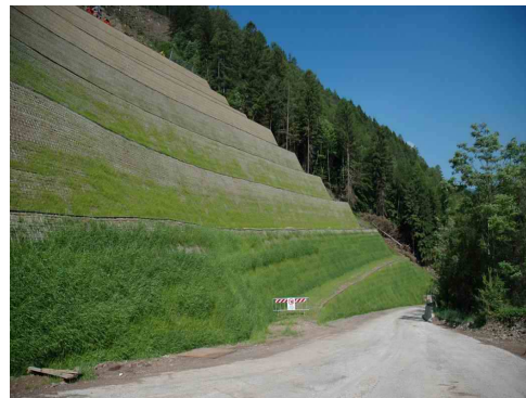
Vista della terra rinforzata dal piede
