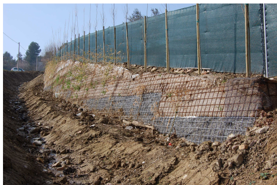
Vista della terra rinforzata a lavori ultimati
