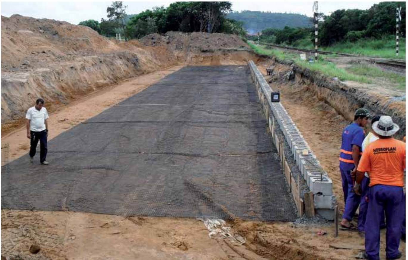
Figura 5 – Colocação das geogrelhas, dos blocos e da brita
