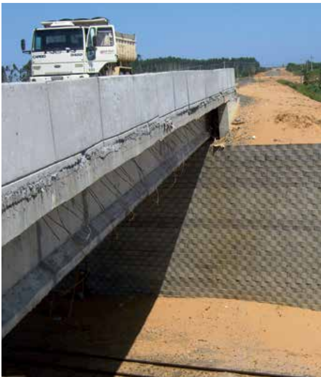
Figura 14 – Detalhe do posicionamento de um caminhão carregado no apoio do viaduto para as medidas das células de carga
