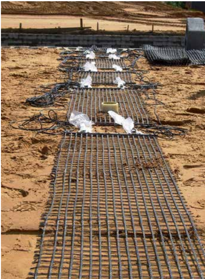
Figura 10 – Detalhe das células de carga utilizadas
