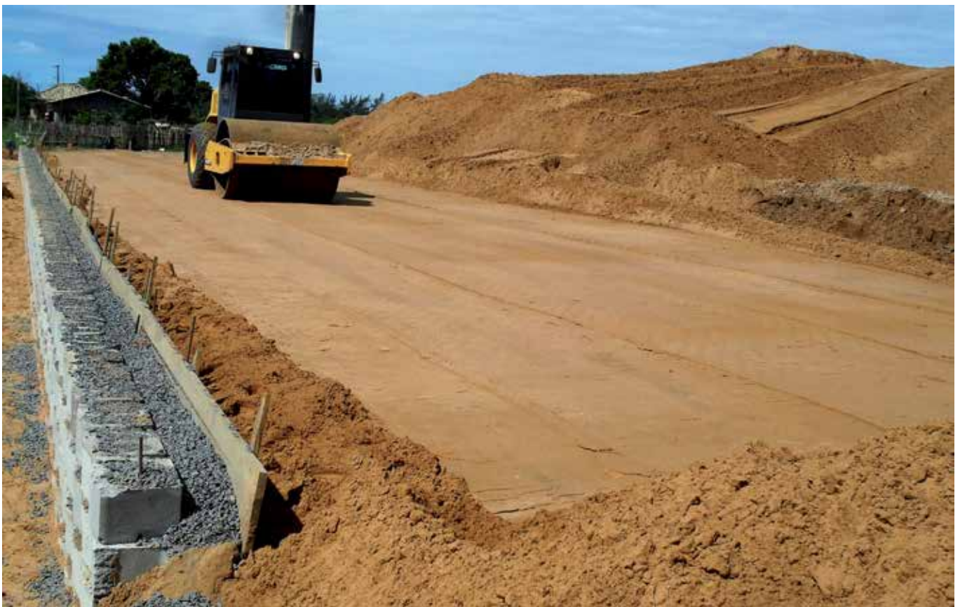
Figura 6 – Compactação do aterro arenoso com rolo vibratório
