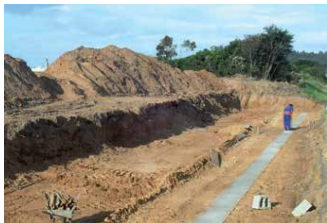
Figura 4 – Fase inicial da construção do muro com a preparação da fundação
