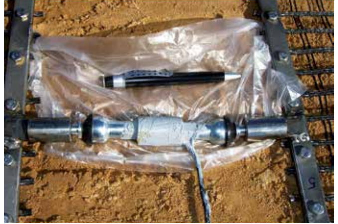
Figura 11 – Posicionamento das geogrelhas instrumentadas na obra
