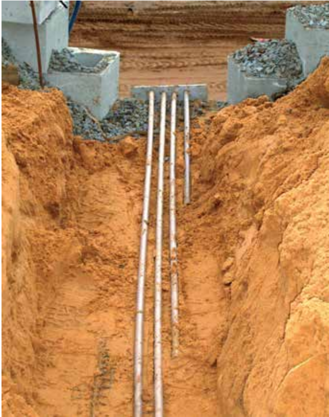
Figura 9 – Detalhe dos tell-tales posicionados no campo
