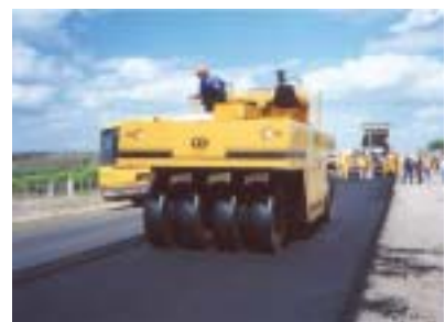
Figura 9 – Procedimento de compactação convencional da capa asfáltica
