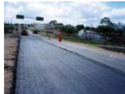
Figura 5 – Aplicação da pintura de ligação na superfície para receber a geogrelha
