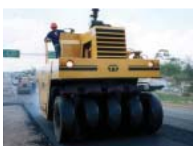
Figura 9 – Procedimento de compactação convencional da capa asfáltica
