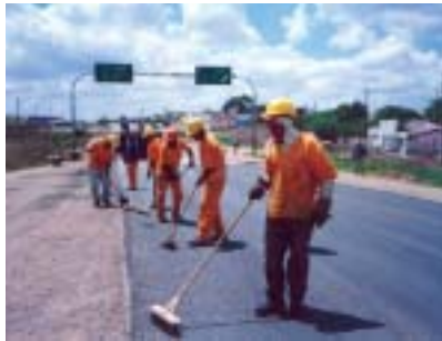
Figura 4 – Limpeza manual e mecânica
