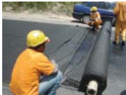
Figura 7 – Sobreposição de geogrelha
