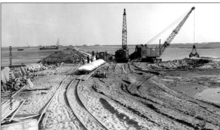
Bild 1. Geokunststoff-Verlegung am Rüstersieler Watt Fig. 1. Geosynthetic installation at Rüstersieler Watt
