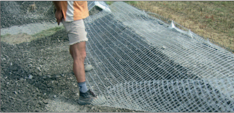
Bild 11. „Memory-Effekt“ bei gelegten Geogittern Fig. 11. "memory-effect" of laced geogrids
