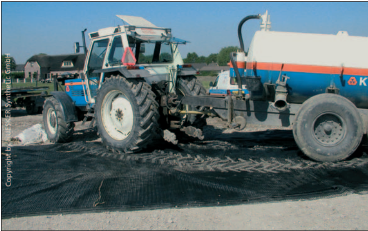
Bild 9. Unsachgemäße Lagerung / Handhabung abgelängter Geogitterbahnen Fig. 9. Inappropriate handling / storage of geogrid
