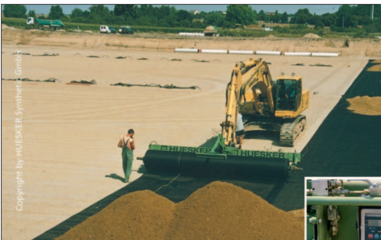
Bild 10. Verlegetraverse und Abroll- und Spannvorrichtung für Geokunststoffe Fig. 10. Equipment for proper unrolling and installation of geosynthetics
