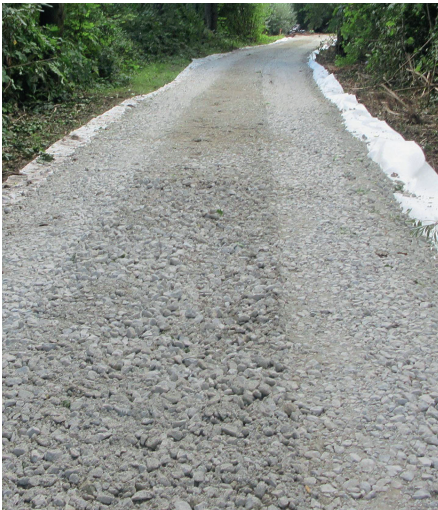
Abb. 4: Baustraße mit Schottererschicht auf biobasiertem Vliesstoff, Dettingen Quelle: [7]
