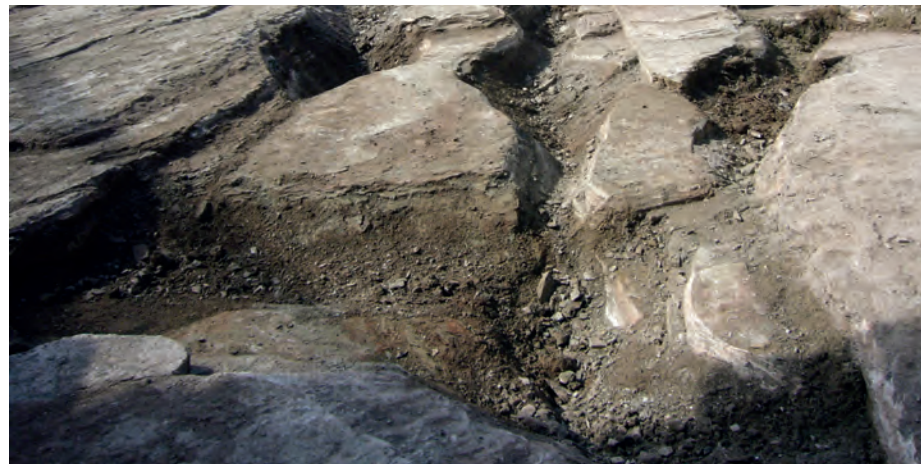
Abb. 9: Gipskarstoberfläche nach dem Freilegen und Beräumen, Stuttgart – Kornal
