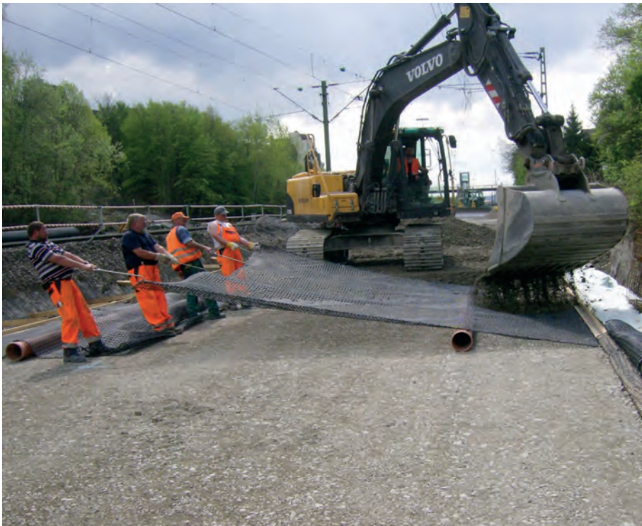
Abb. 11: Vorgehensweise zum Anspannen und Fixieren eines Geogitterrückumschlags
