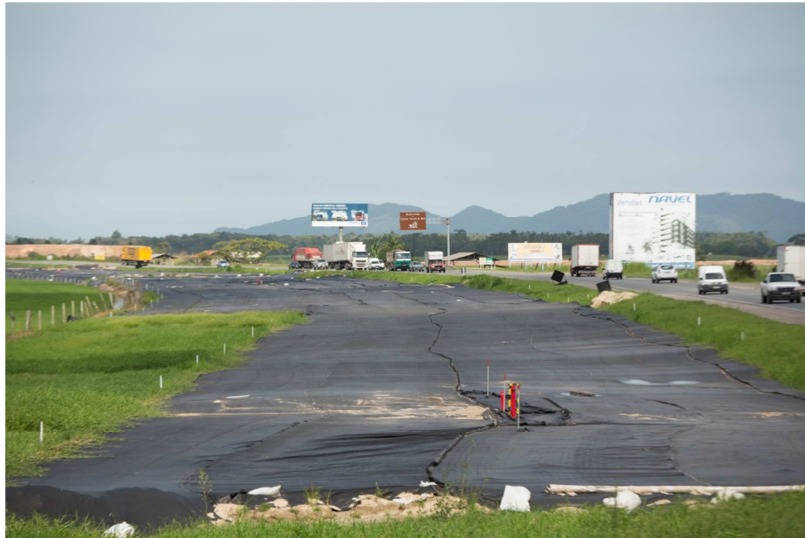
Figura 01 – Aplicação do geotêxtil tecido como camada de separação.
