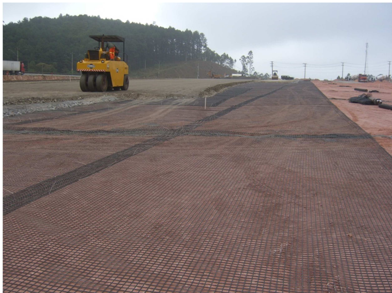
Figura 01 – Aplicação da geogrelha como reforço camada de base.
