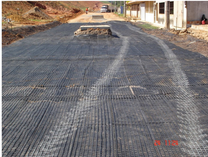
Figura 03 – Aplicação de um geocomposto para reforço de base de pavimento.
