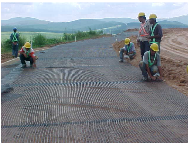
Figura 10. Detalhe da instalação dos painéis de geogrelhas de PVA.
