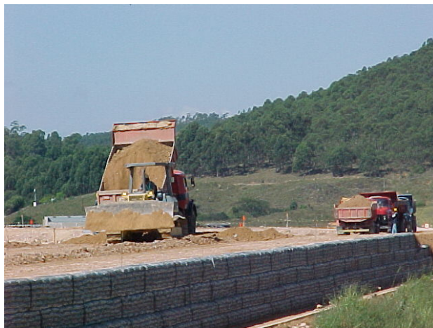
Figura 11. Vista panorâmica da execução do aterro reforçado.
