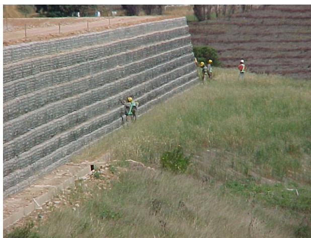
Figura 12. Vista frontal do aterro reforçado durante os trabalhos de hidrossemeadura da face.
