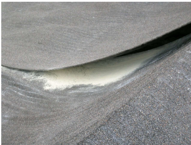
Figura 4: Esempio di sormonto realizzato con della bentonite in polvere.
