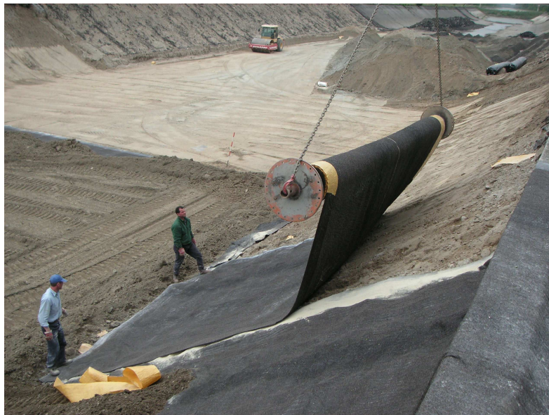
Figura 6: Posa del GCL con pendenza rilevante
