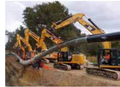
2014 Pipe encasement, France, Artère de l'Adour, gas pipeline
