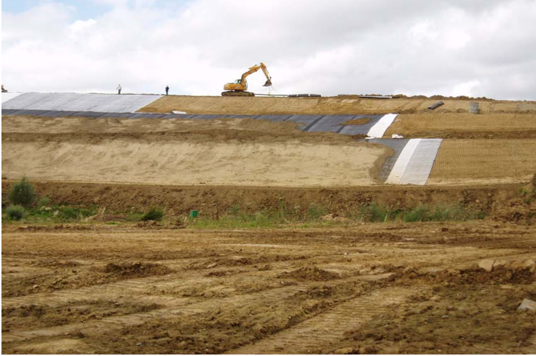
Photographie 5. Vue d'ensemble en talus : profilage, étanchéité, drainage, renforcement et terre végétale (SITA Nord – SCETAUROUTE)
