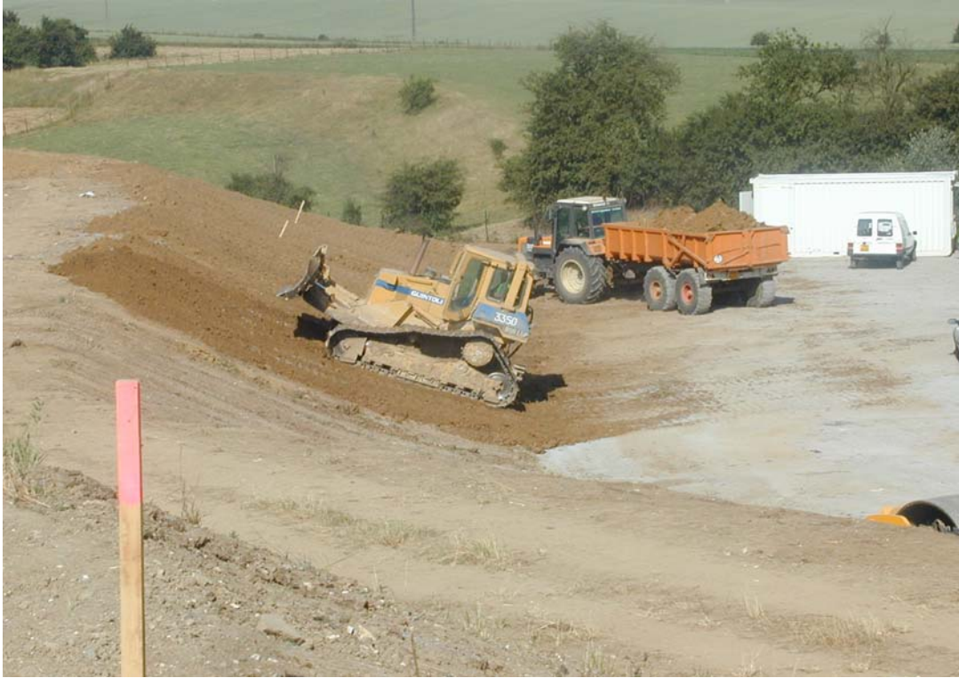
Photographie 1. Limon semi-perméable ( k < 10^{-6} \text{ m/s} ) en talus (SITA Nord – SCETAUROUTE)
