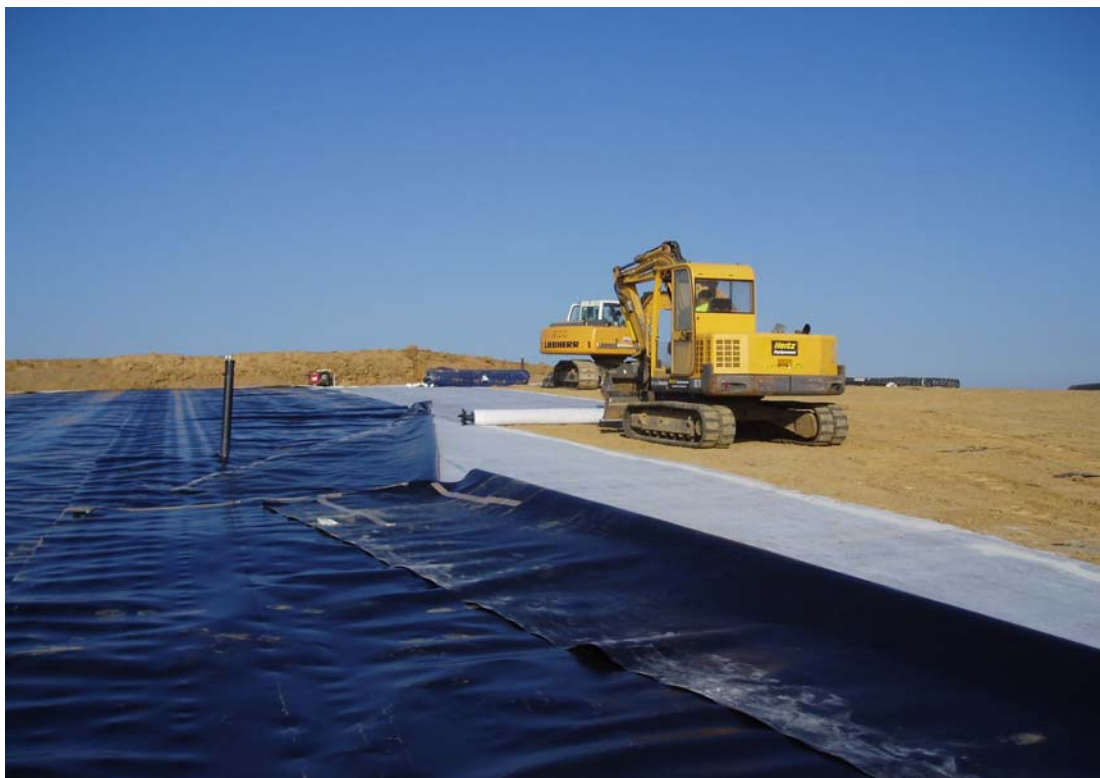
Photographie 4. Sur le dôme : limon semi-perméable, GSB et géomembrane PEHD (SITA Nord – SCETAURROUTE)
